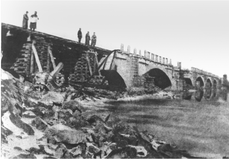
Зруйнований залізничний міст через Сиваш. Крим, 1920 р.
