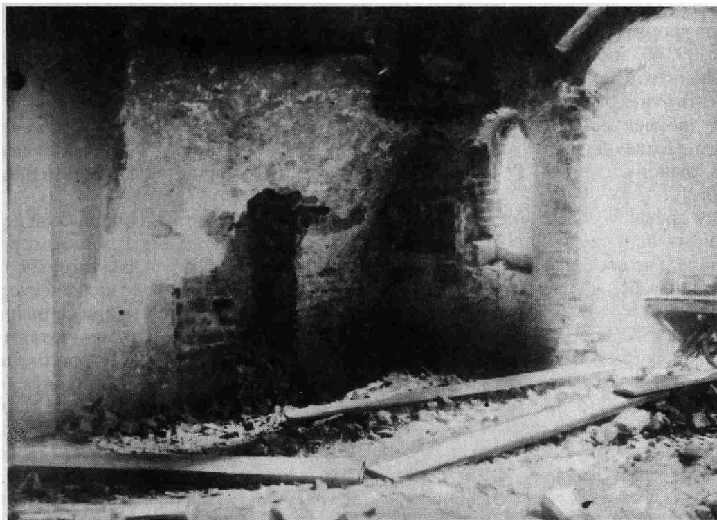
Рис. 7. Остатки кладки барабана и кровельной выстилки из чернолощеной черепицы над сводом древнего храма
