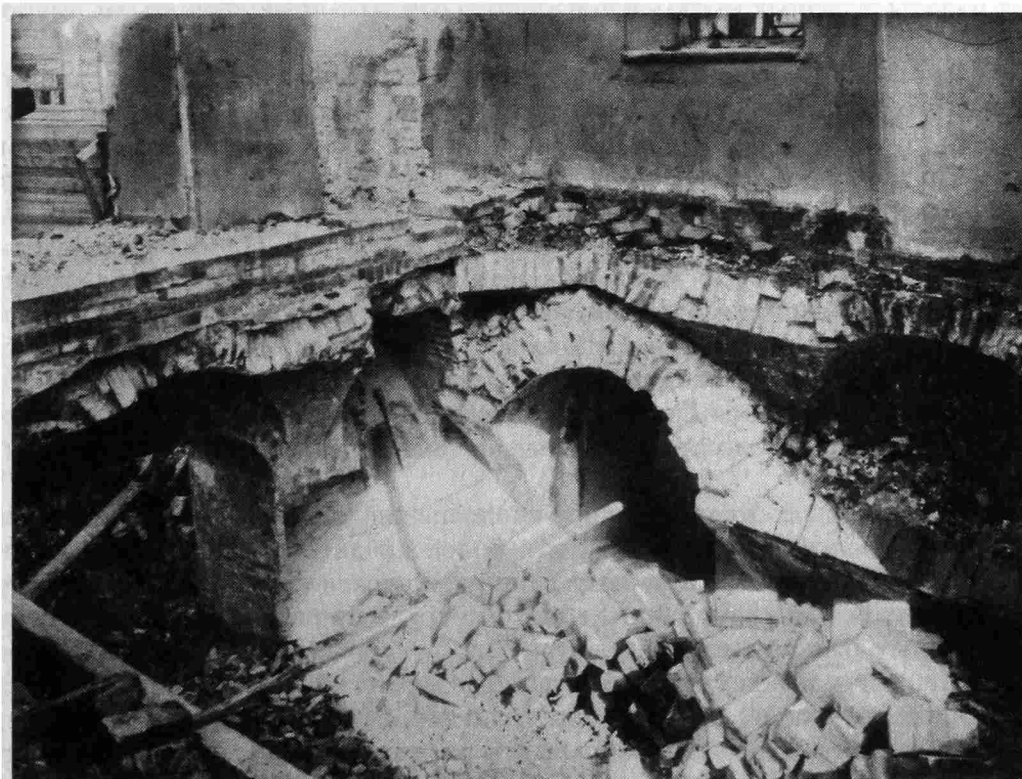
Рис. 8. Северо-восточный угол подклета Никольской церкви (древней трапезной). Видны раскрытое древнее окно, остатки распалубок первоначального свода, нижняя часть двери в северной стене
