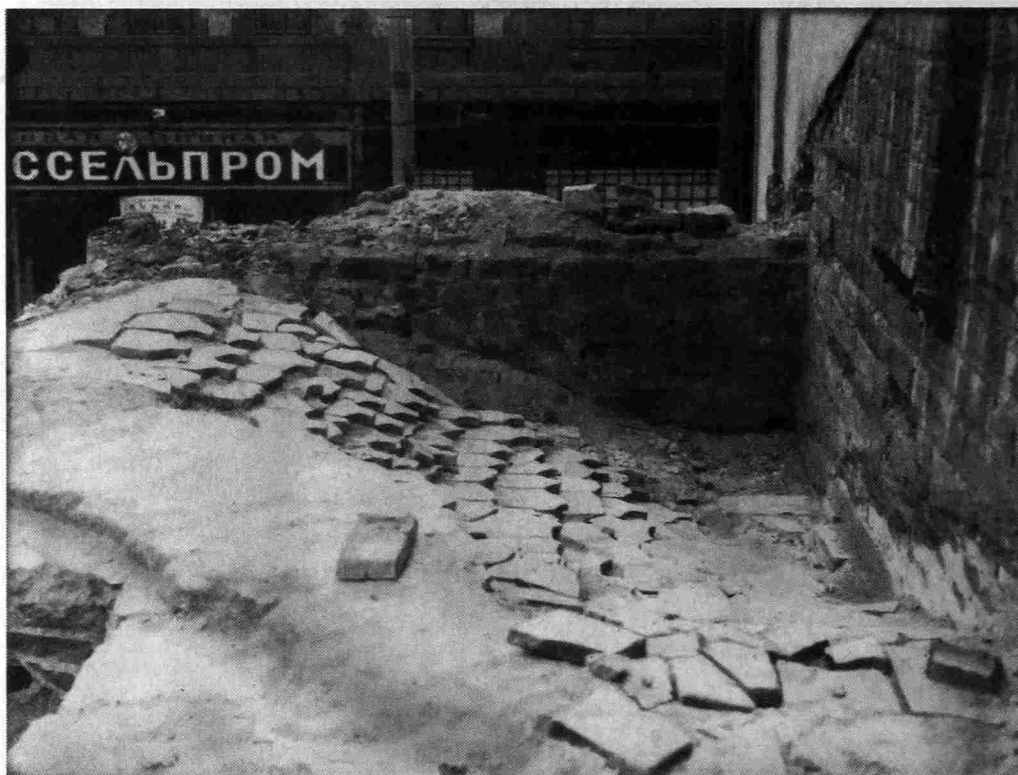
Рис. 6. Разборка свода над подклетом алтаря Никольской церкви. Частично раскрыт дверной проем, который вел в жертвенник древнего храма
