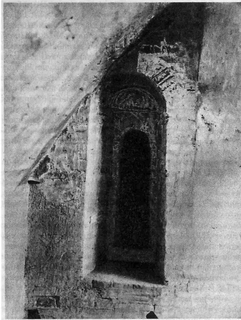
Рис. 9. Юго-восточный угол подклета Никольской церкви после разборки свода XVII в. Видны распалубки свода трапезной древнего храма
