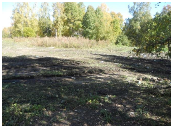
После проведения работ
