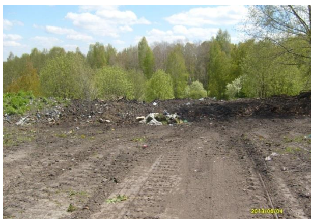
До проведения работ
