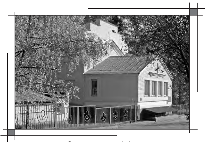
Здание реактора Ф-1
