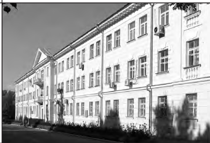
Здание Лаборатории № 2 (Главное здание)
