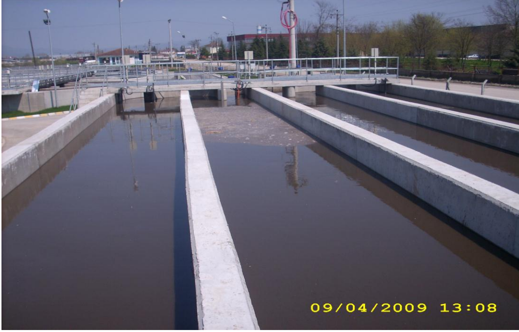
Şekil.D.14: Biyofosfor Ünitesi
