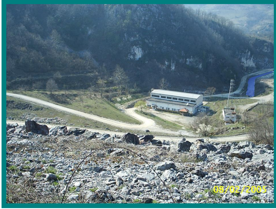
Şekil J.1: Hasanlar Barajı Hidroelektrik Enerji Üretim Santrali
