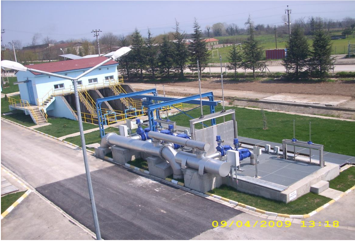
Şekil.D.18:Ana terfi pompa istasyonu
