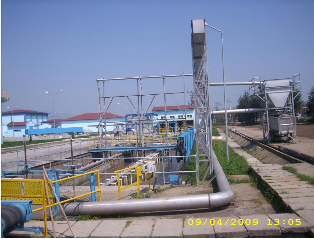
Şekil D.10.Havalandırma Kum Tutucu Ünitesi
