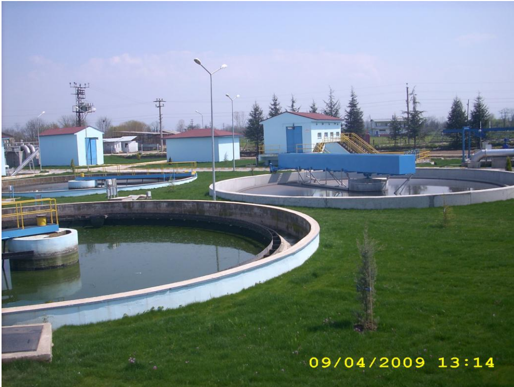
Şekil D.11.Ön Çökeltme Havuzları
