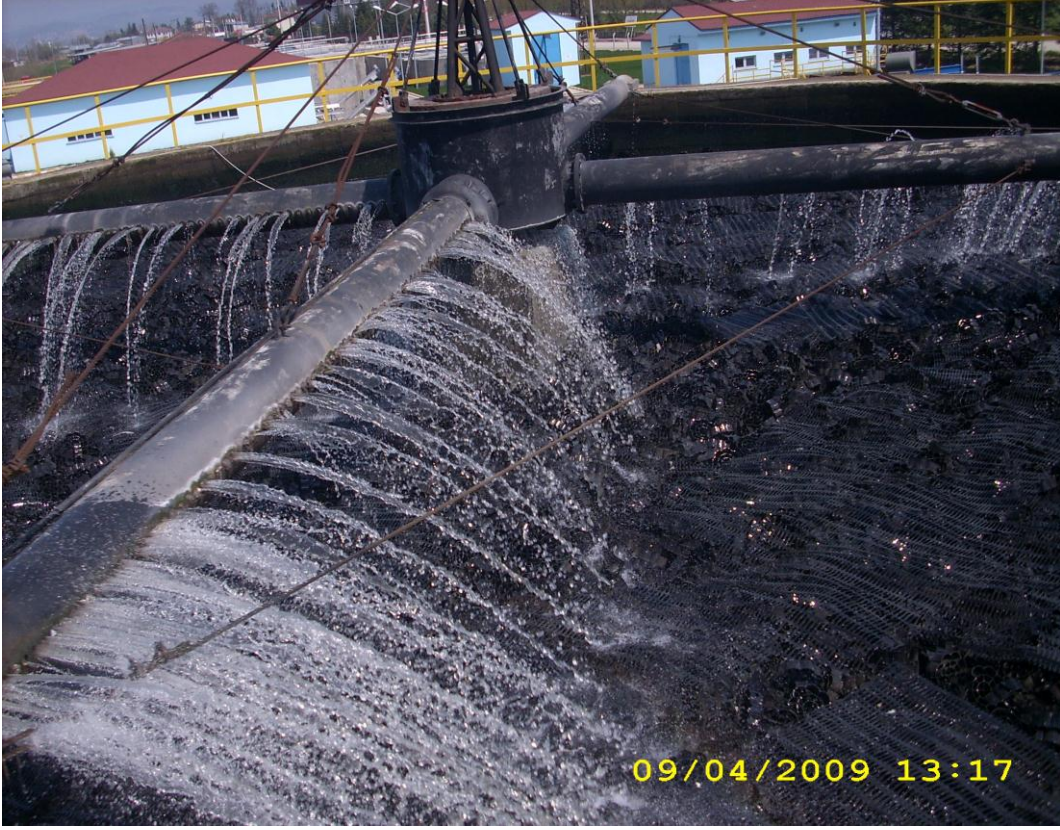
Şekil D.12: Damlatmalı Filtreler
