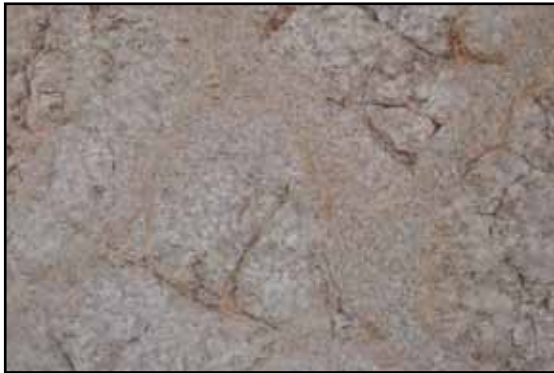
Resim 16: Çatlaklıkların kapatılmış hâli.
