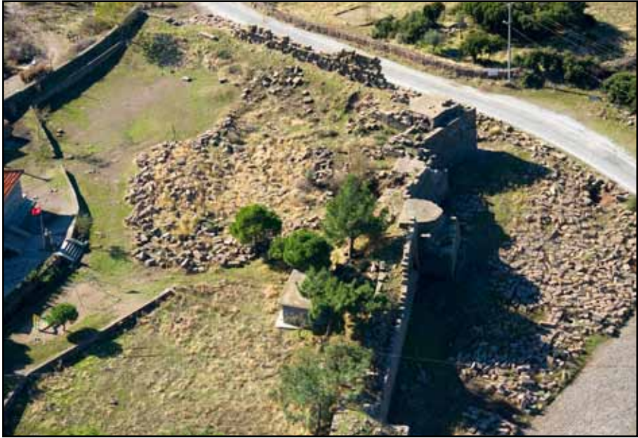
Resim 13: Surlar,1 No.lu kapı etrafındaki yapı öğeleri.
