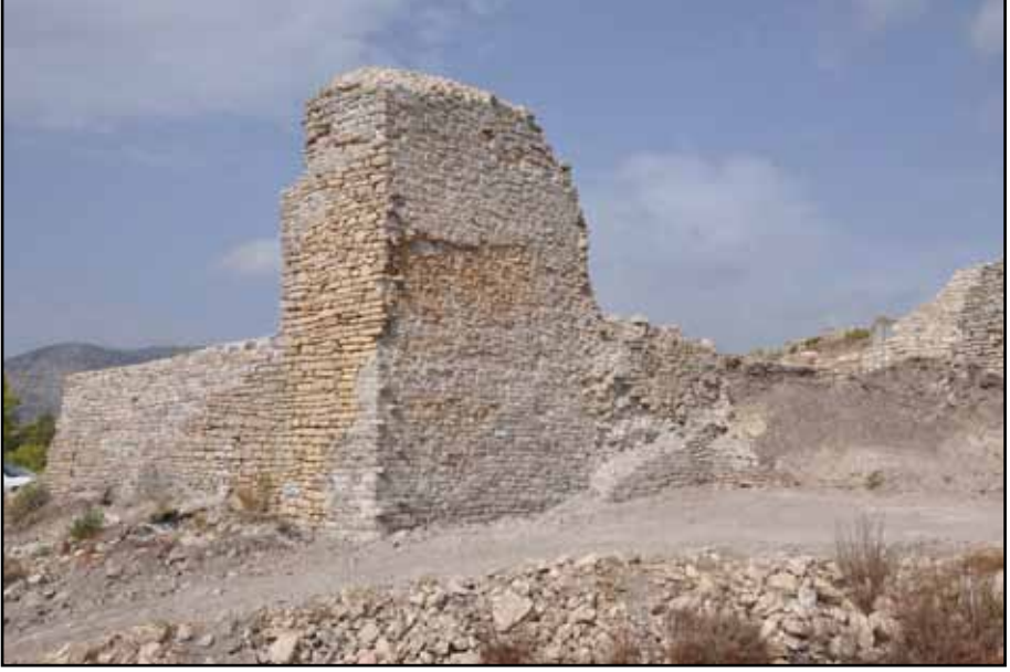
Resim 13: Asklepieion Nişli Duvarı Dışı, onarım sonrası
