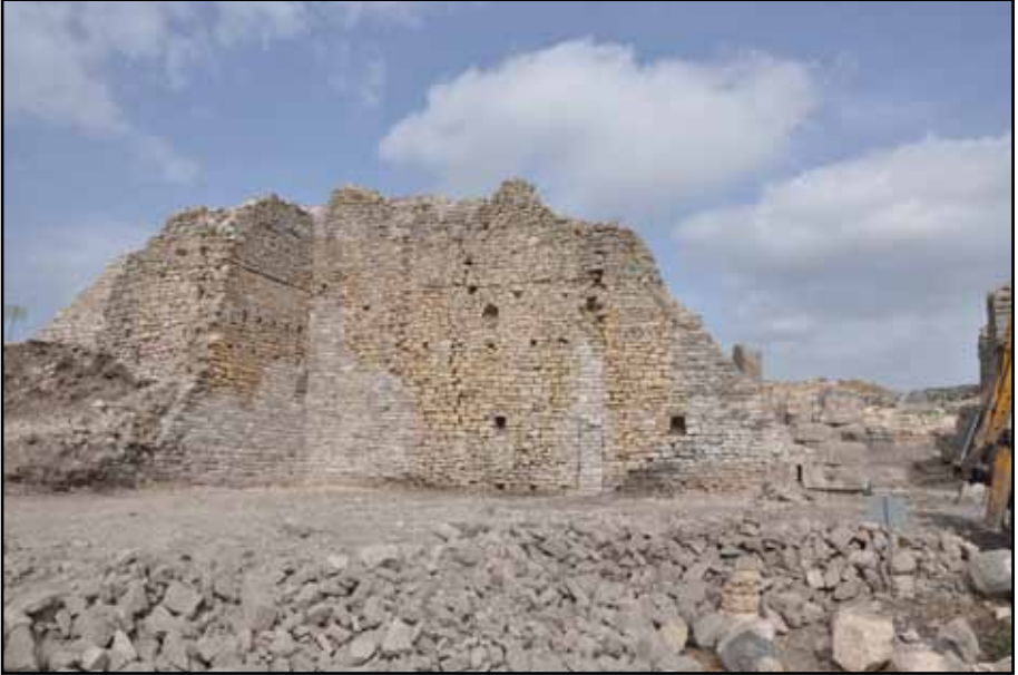
Resim 11: Hadrianeum ve Asklepieion dış duvarları, onarım sonrası
