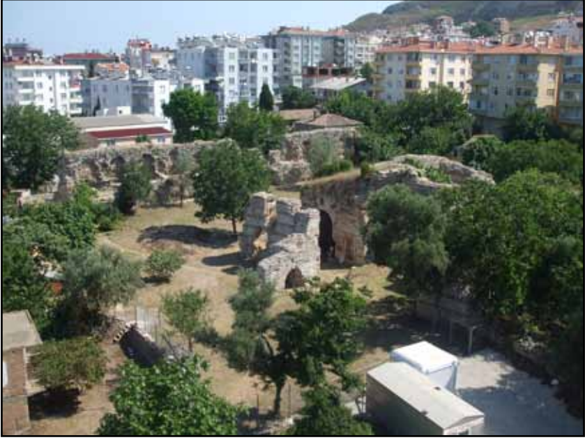
Resim 1: Yapının genel görünümü
