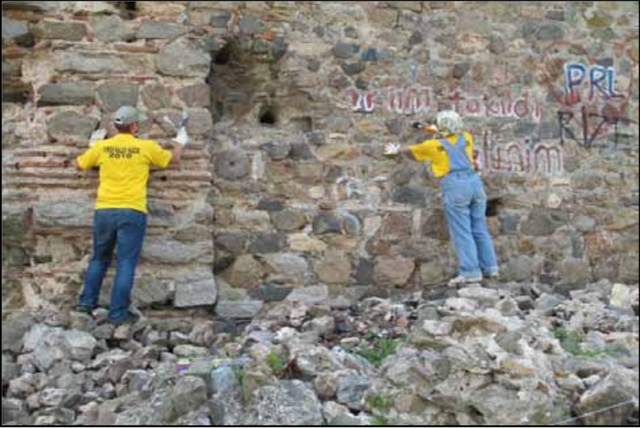
Resim 11: Duvar yazılarının temizliği
