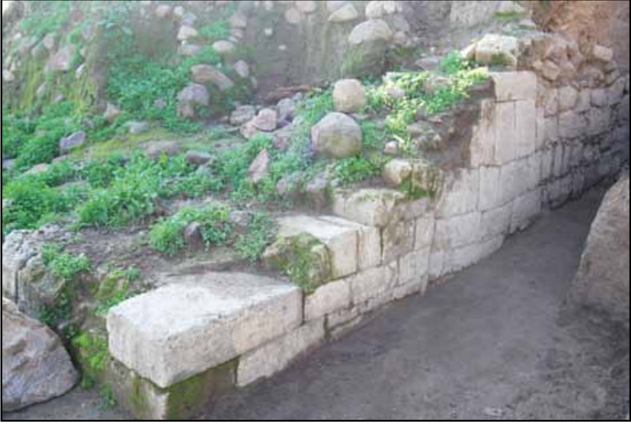
Resim 8: Tüf yapı batı duvarı.
