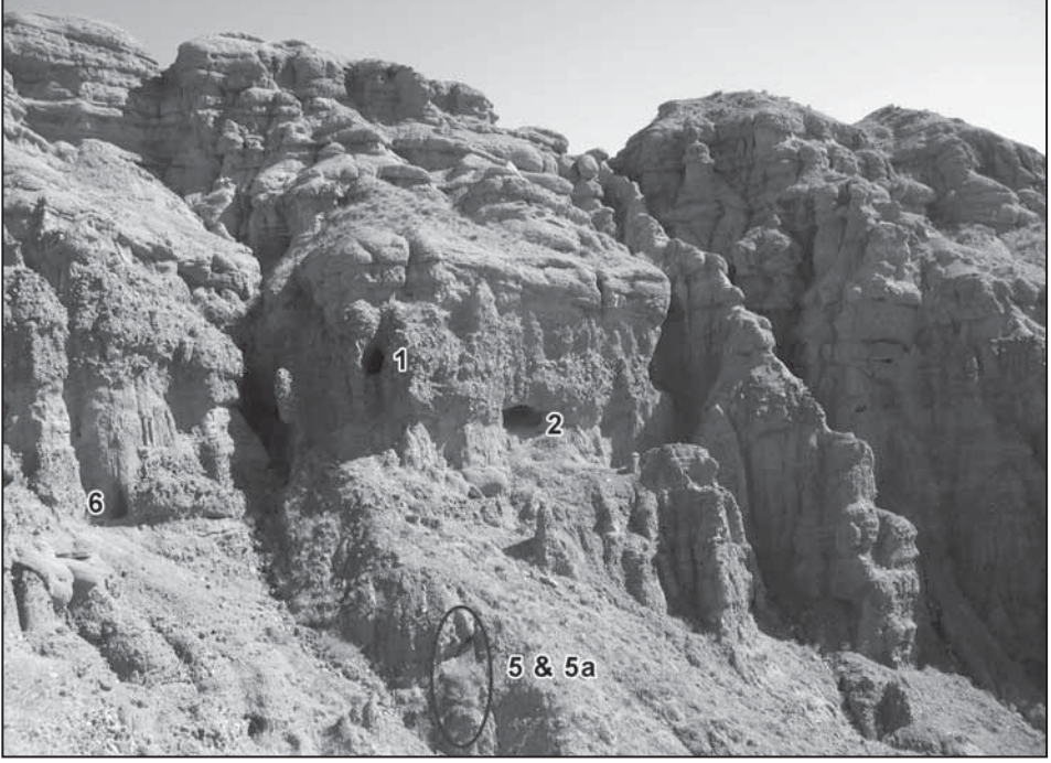
Resim: 9: Maztönü Mevkii maden işletme galerileri. 1 ve 2 No.lu galerilerin aşağısında yapay yığıntı toprak altında saklı 5 ve 5a galerilerinin konumu kırmızı elips içine alınmıştır.
