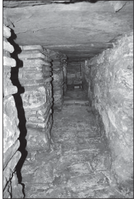
Resim 10: Kum Kasrı Hamamı'nın cehennemlik katındaki sıcak su buharının dolaştığı kanallardan bir görünüm
