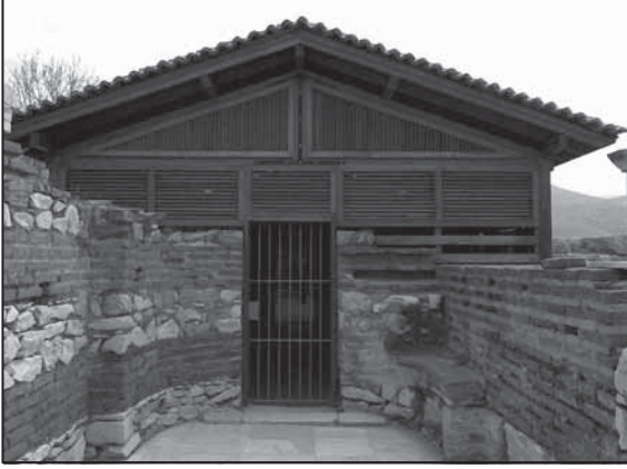
Resim: 14: Şapel koruyucu çatısının yeni hali.
