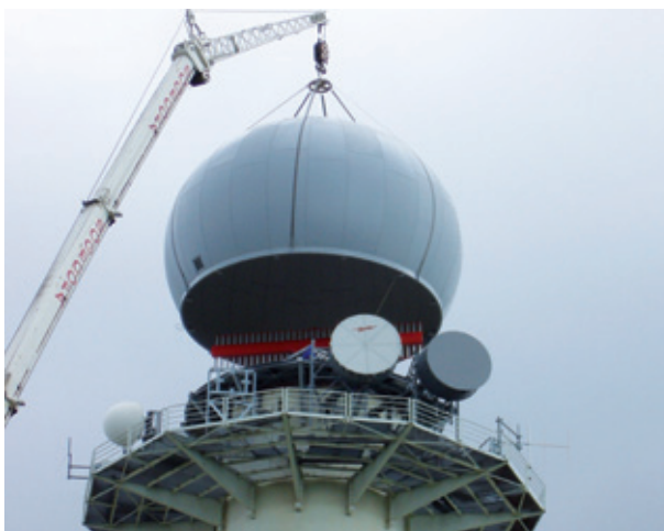
Pose du radôme du radar de Pierre-sur-Haute
