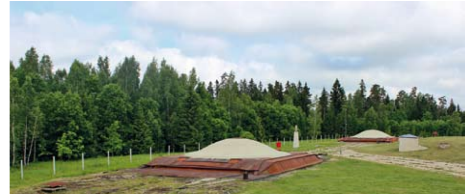
POUZDRO NA RAKETU. Hloubka síla byla 24 metrů, což odpovídalo délce sovětské střely typu R-12 Dvina s nasazenou jadernou hlavici.
