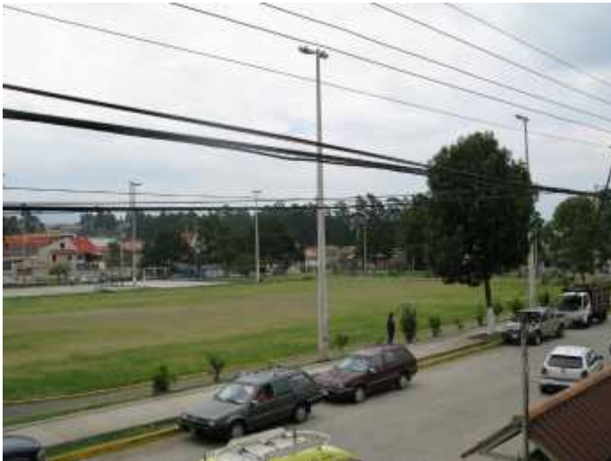
EDIFICACIONES, ÁRBOLES ALTOS, CABLES DE TENDIDO ELÉCTRICO
