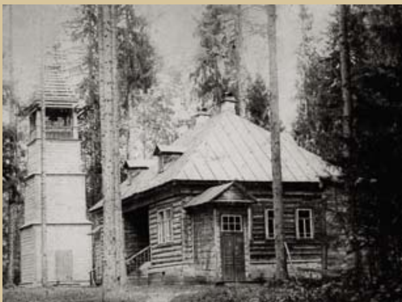
Монашеские кельи и строящаяся колокольня в Софрониевой пустыни
