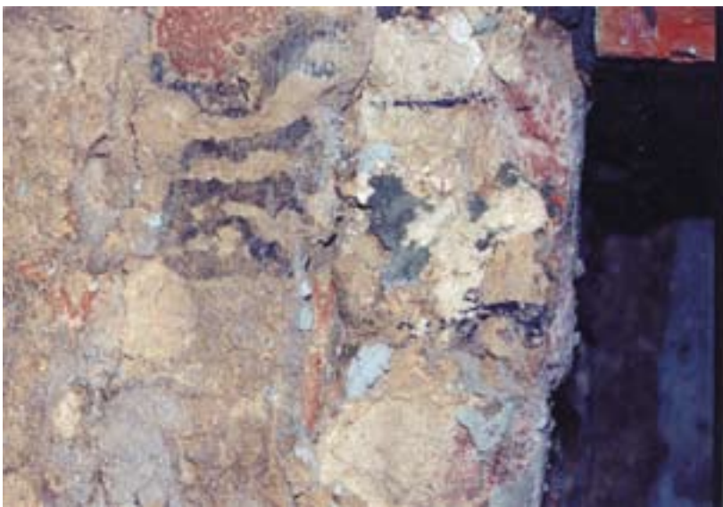
Потёки копоти на сохранившейся стене кельи. Фото В. Руднева
