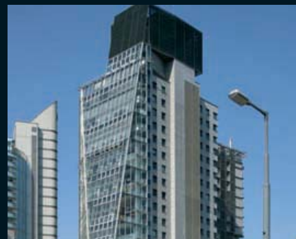
Gasometer B. Wien, (1995-2001) Wohn- und Bürogebäude Schlachthausgasse. Wien, (2001/2003-05) SEG Apartment Tower. Wien, (1994-1998)
