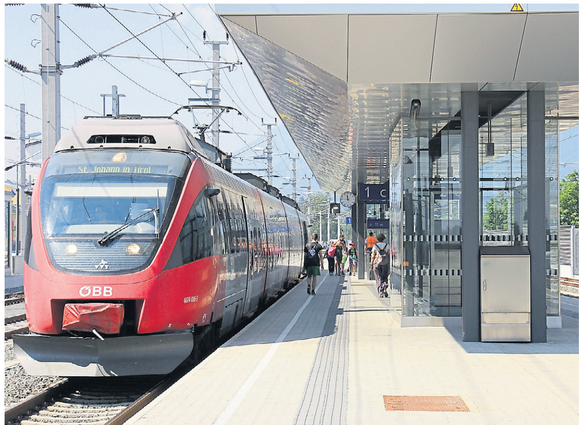
Für 21,5 Millionen € wurde der Bahnhof Brixlegg modernisiert. Jetzt präsentiert er sich als umweltfreundliche Drehscheibe des Verkehrs.
