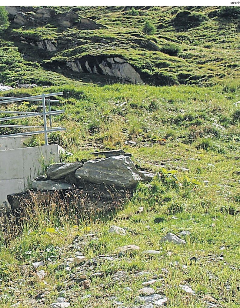
Kleinwasserkraftwerk am Dorferbach.
