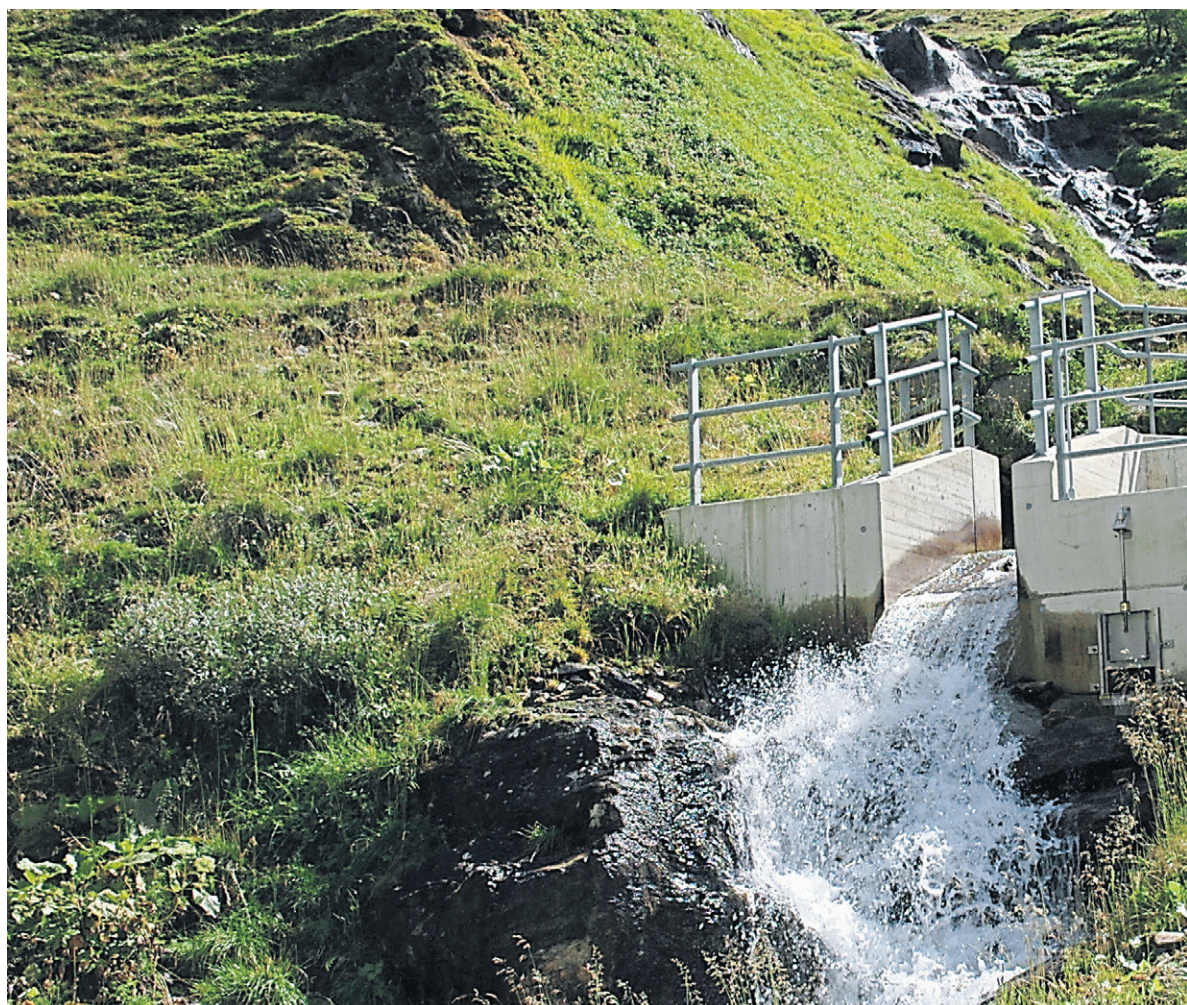
Für die Kleinwasserkraft bedeutet das EuGH-Urteil eine große Hürde. Im Bild: Wasserfassung für ein
