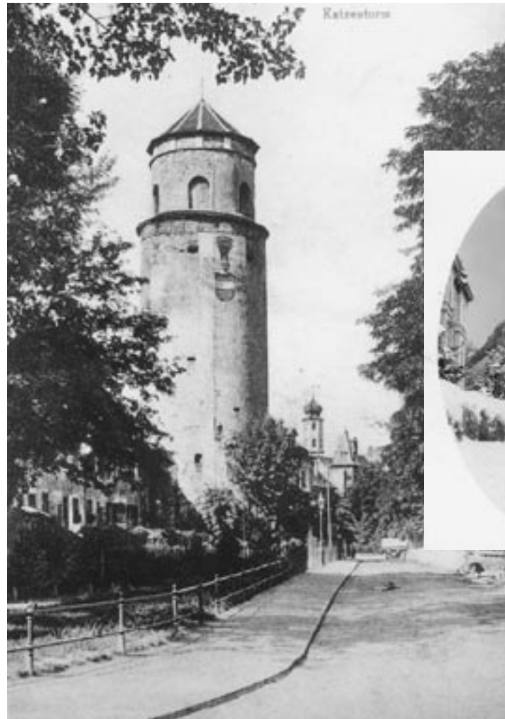
Der Hirschgraben mit Katzenturm um 1900
