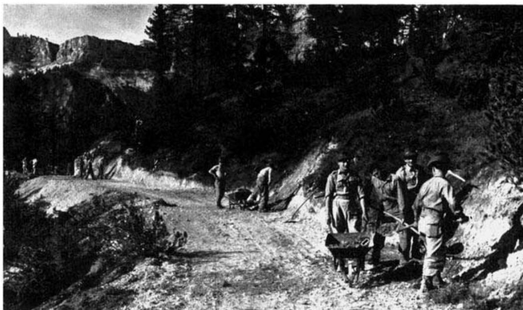
Reparti alpini costruiscono la strada di accesso alla pista dello slalom gigante sul Pian della Bigontina, che fu ultimata nell'estate 1955.
