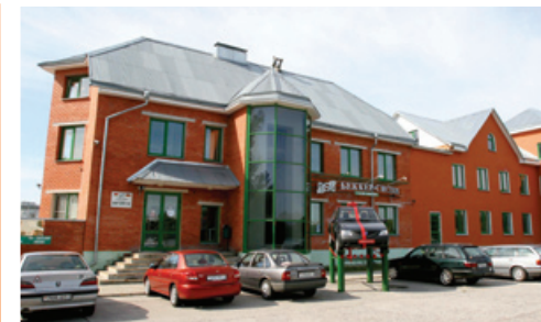
Здание офиса предприятия «Беккер-Систем» в СЭЗ «Гомель-Ратон»
