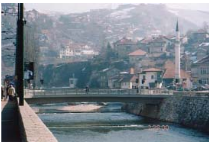
紛争時に一旦は破壊された橋も 2000 年には修復が完了した。
