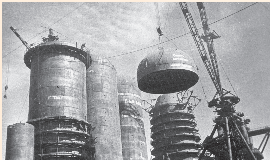
Строительство шестой доменной печи в Магнитогорске, 1943
