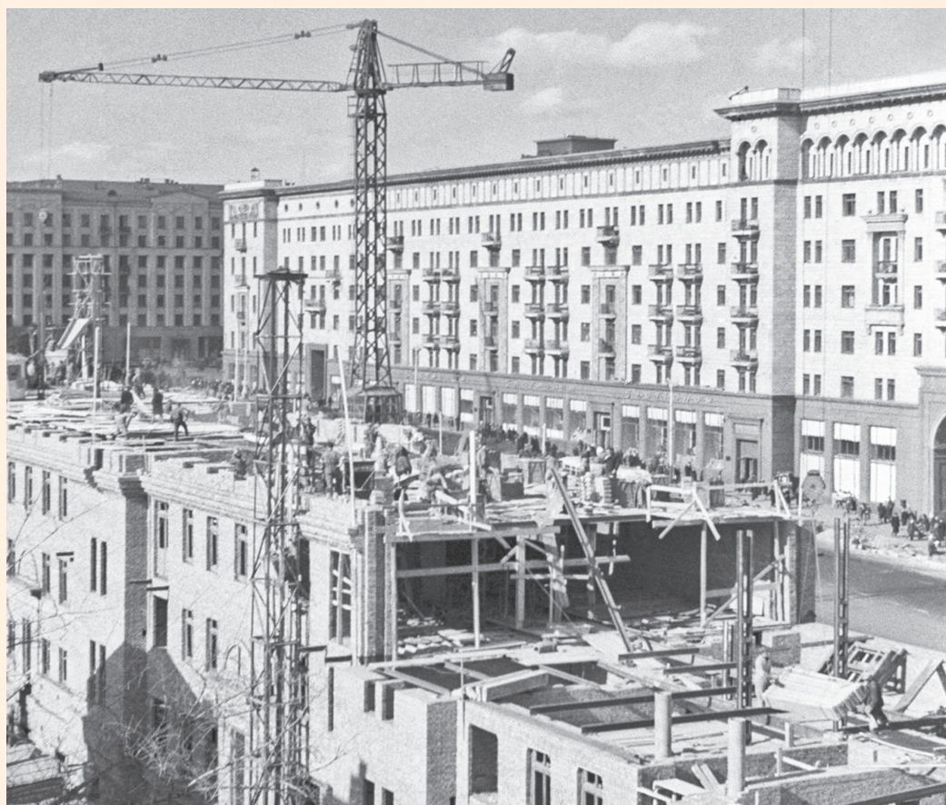
Строительство жилых домов на улице Горького в Москве, 1946
