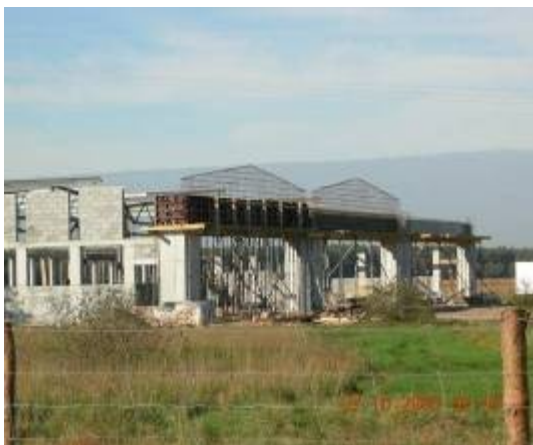
Ryc.11. Hangary o powierzchni blisko 1375 m 2
