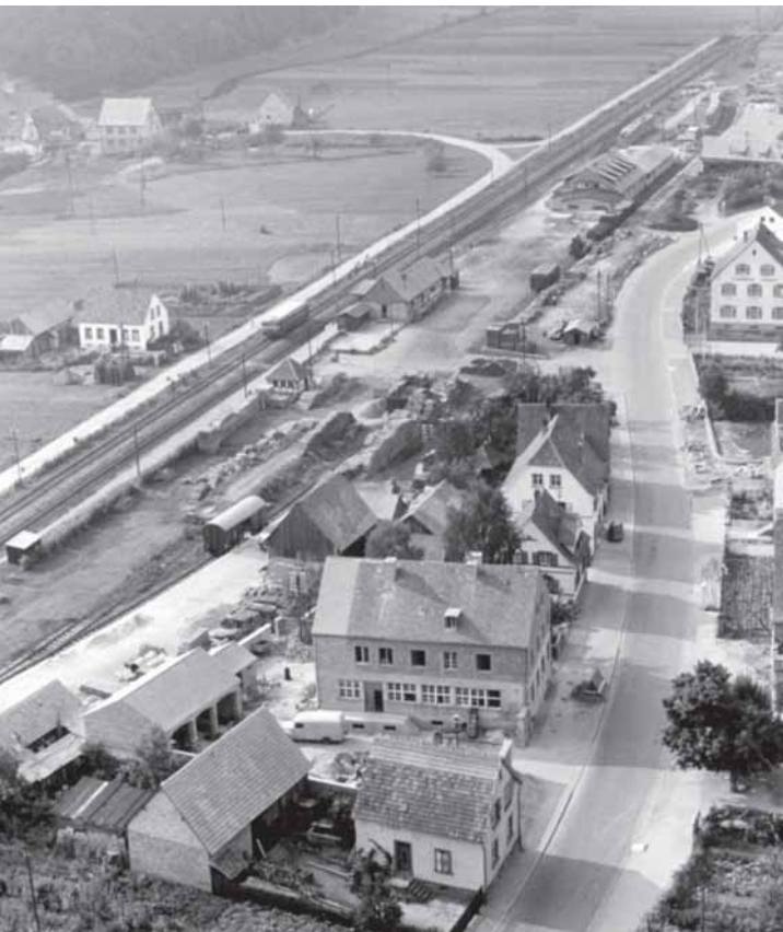
Ein kleiner Zug in großer Landschaft: Die Direktionsgesellschaft erklimmt den Jungfernsprung und ermöglicht uns so den Überblick auf den Bahnhof Dahn. Noch fehlt das kriegszerstörte Gebäude. (Aufnahme Adolf Dormann, Sammlung Wolfgang Löckel).
