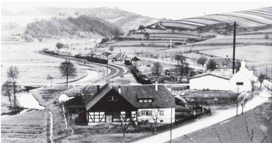
Der Bahnhof Bundenthal in einer Übersichtsfotografie kurz nach der Betriebsaufnahme. Die weitläufigen Anlagen beinhalten einen Lokschuppen, eine Rampe, sowie eine (auf dem Bild nicht erkennbare) Drehscheibe. Die Anlagen der Kleinbahn nach Ludwigswinkel wurden links der Wieslauter angelegt (Aufnahme Sammlung Karl Kissel)
