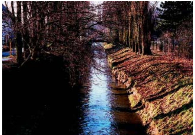
Abb. 3.2.7.2: Rotbachunterlauf; begradigter und befestigter Bach im Siedlungsbereich, Trapezprofil
