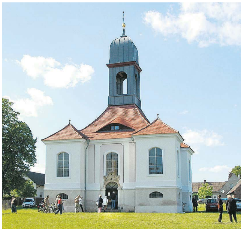
Als „Juwel von Reuden“ wird die Gutskapelle im Zentrum des Dorfes angesehen. Der Förderverein um Pfarrerin Martina Schmidt bündelt Kräfte und Mittel, um das Gebäude weiter zu sanieren. Herzenswunsch vieler: eine Glocke, die das Erscheinungsbild der Kapelle zusätzlich akustisch betont.
