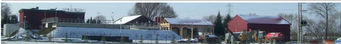
Oczyszczalnia ścieków w Haczowie
