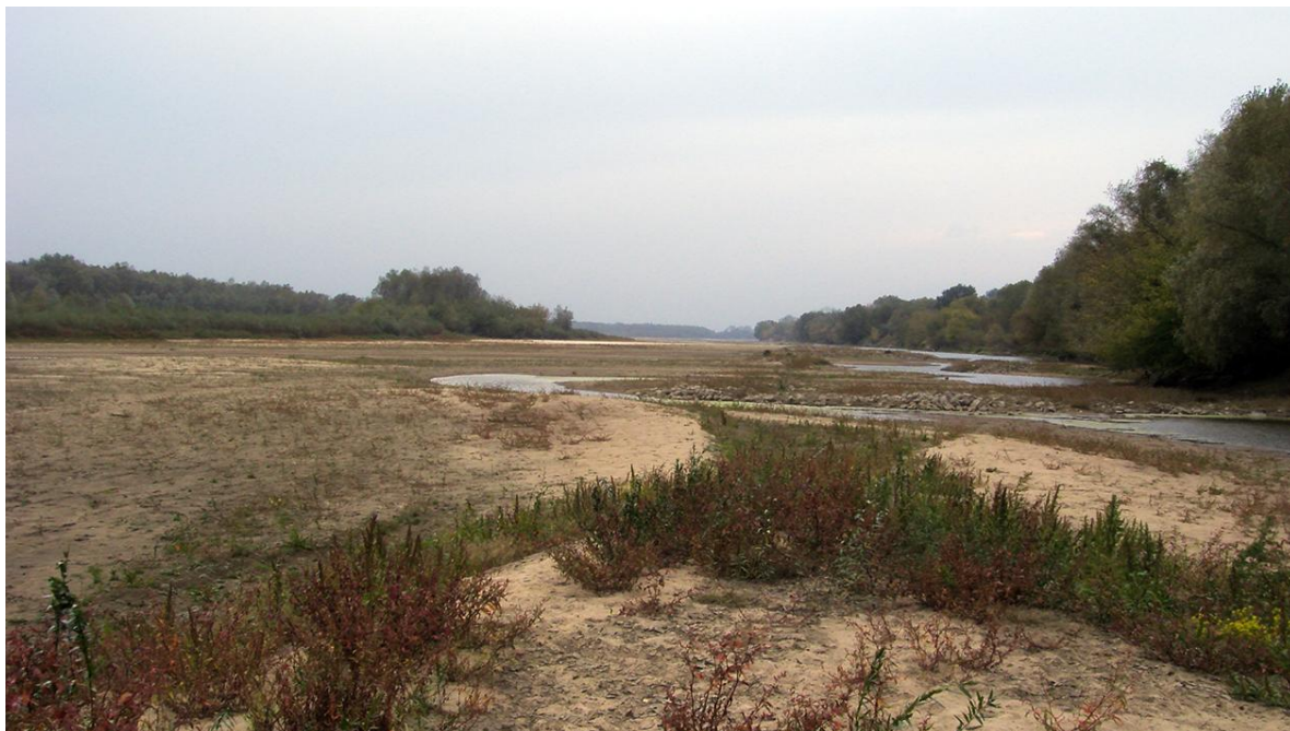
Fot. 80. Dno zapiaszczonego prawego ramienia Wisły w rejonie km 534,5. Wysokość odsypów osiąga poziom korony przerwanych przetamowań (dawnych ostróg sięgających koryta głównego)
