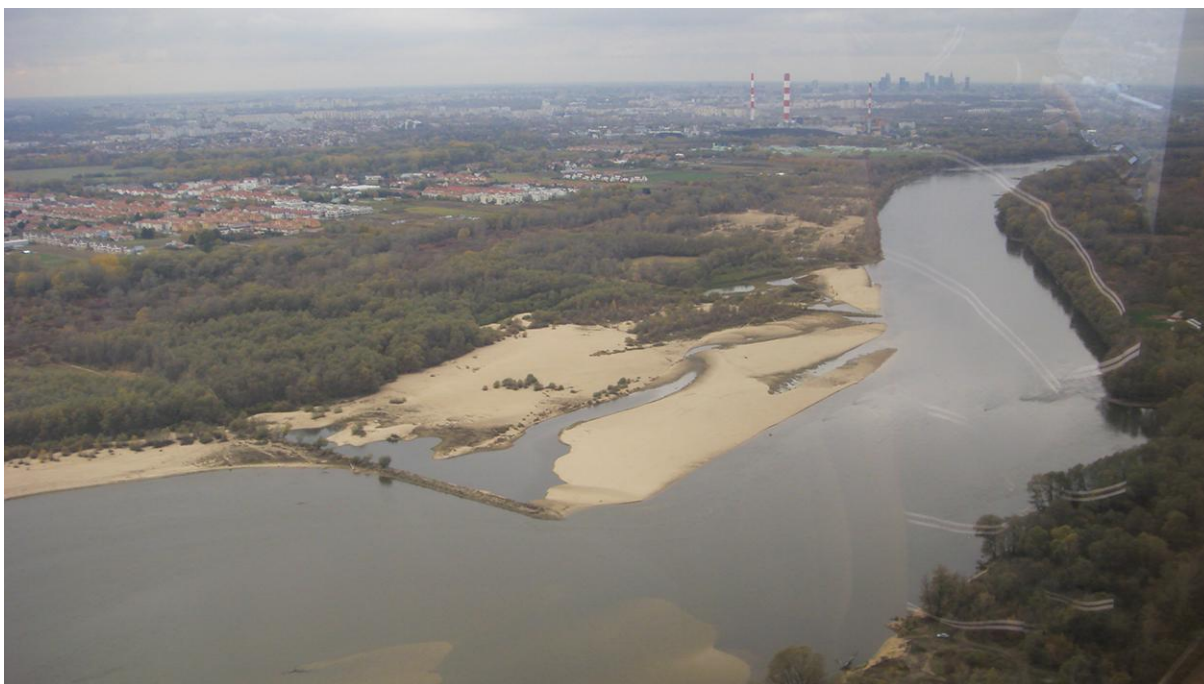
Fot. 89. Lewy brzeg Wisły w rejonie proponowanej lokalizacji. Widoczna skokowa zmiana szerokości sąsiadujących odcinków oraz podwodne formy rumowiska wprowadzanego w odcinek uregulowany
