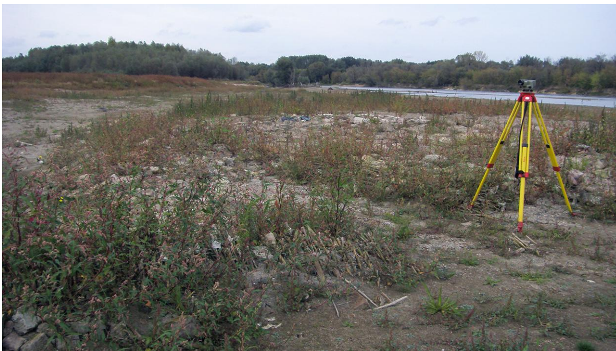
Fot. 82. Wysokość odkładu na wlocie do bocznego ramienia rzeki (po lewej) i zwarta budowa koryta (po prawej). Na pierwszym planie zniszczona stara ostroga w km 530.
