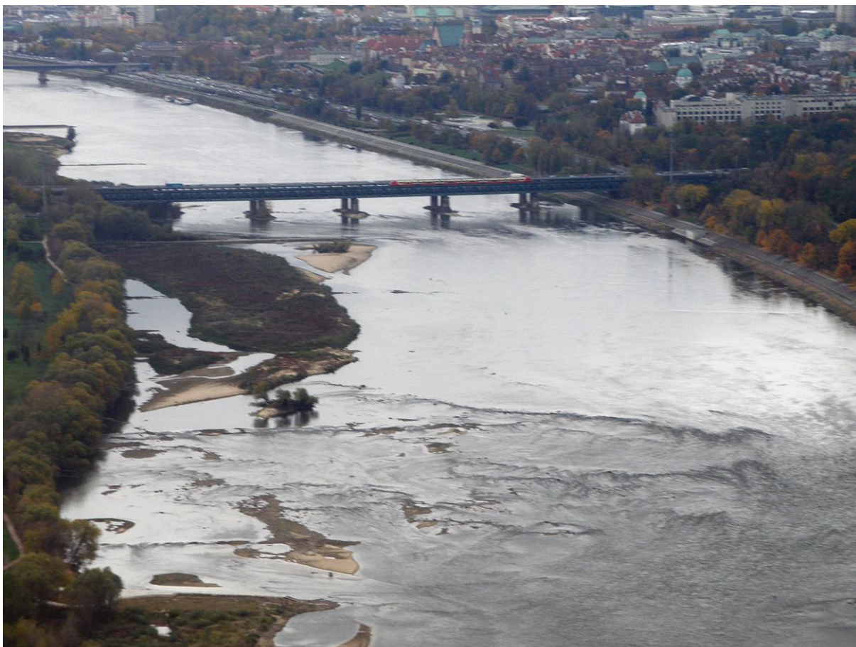
Fot. 84. Ogólny widok koryta w rejonie planowanych modyfikacji koryta w km 516
