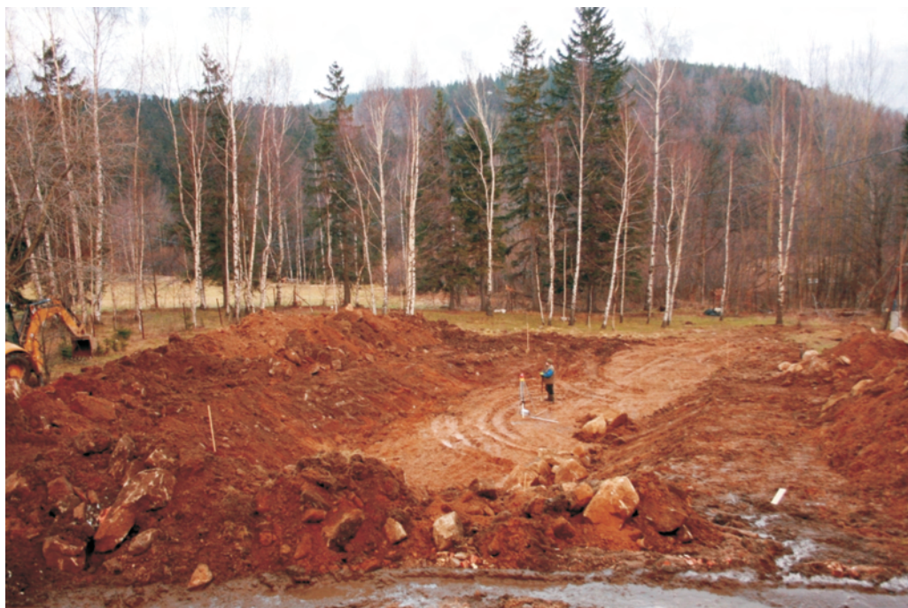
Fot. 16-18. Etapy poziomowa- nia zbocza i formowania skarp
