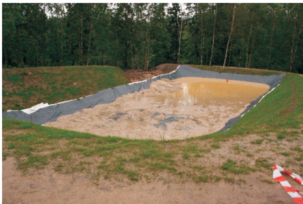
Fot. 19. Uszczelnienie złoża za pomocą folii PVC.
