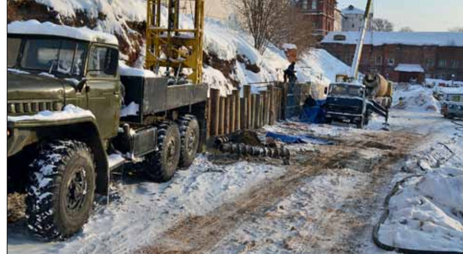
Зима 2012–2013. На стройплощадке нового общежития укрепляют западный склон и конструкции Плотничьей башни
