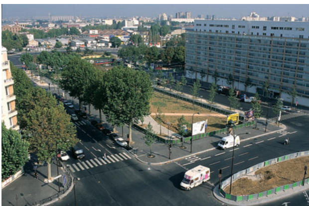
Le mail central aménagé sur l'avenue de la porte d'Aubervilliers qui accueillera à terme le tramway SDEV
