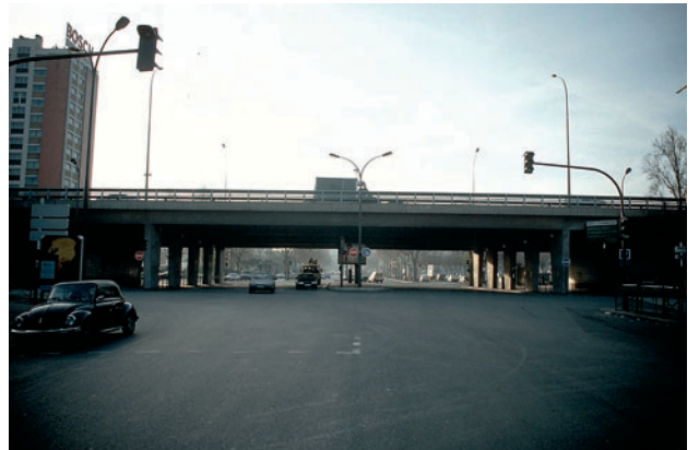
Le franchissement en « porte », porte de Clignancourt
