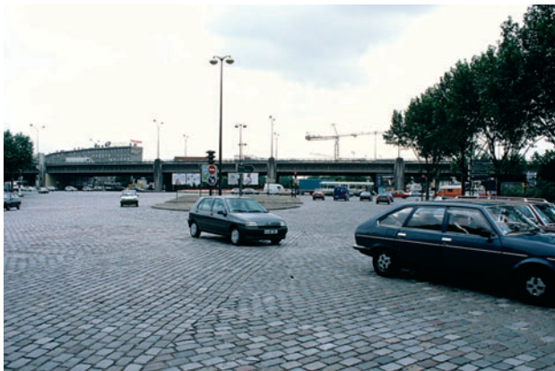
L'espace très routier et le surdimensionnement de la chaussée, porte de Pantin
