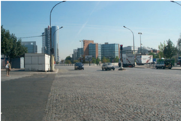
Le franchissement en « pont » porte de Montreuil, vue vers la banlieue
