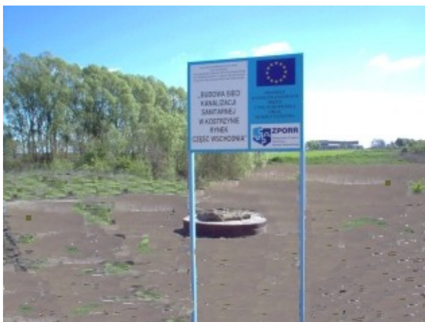
Zdjęcie 11 Kanalizacja we wschodniej części Rynku – dofinansowanie ze ZPORR-u
