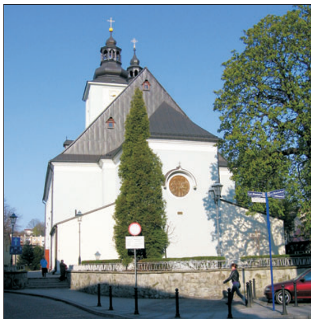
Elewacja wschodnia widoczna z narożnika ul. Bielskiej.
