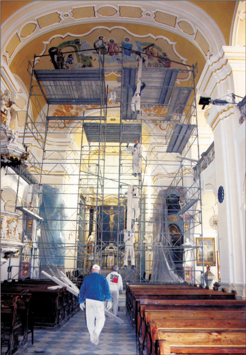
Nawa główna w czasie robót renowacyjnych polichromii na sklepieniach. Stan – marzec 2011 r.
