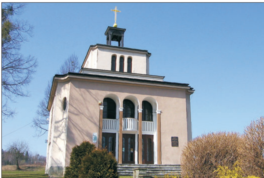
Elewacja główna, od strony miasta.
