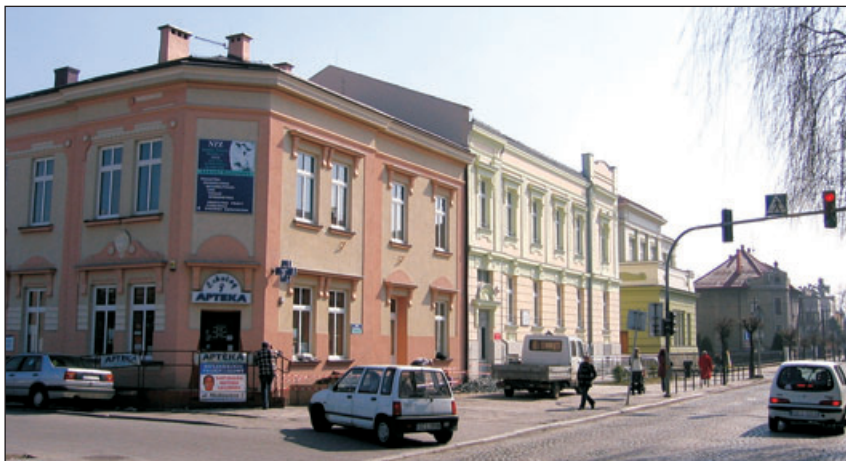
Widok narożnego budynku nr 7 przy placu parkingowym.
