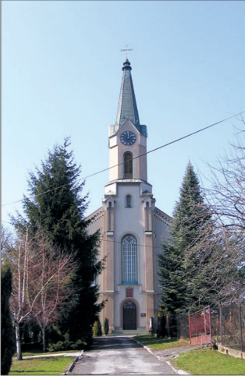
Elewacja wschodnia, od strony miasta.
