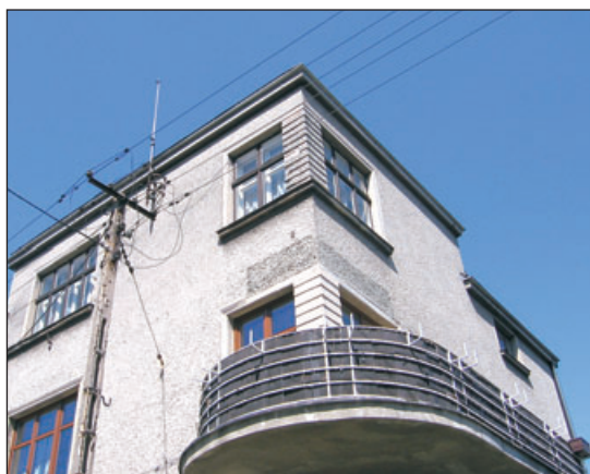
Fragment elewacji budynku nr 35.
