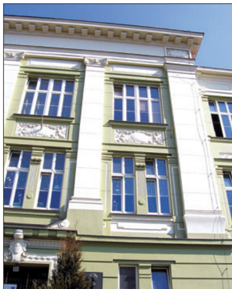
Fragment elewacji głównej.
