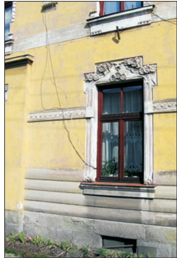
Fragment elewacji od strony ulicy.
