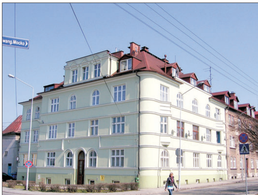
Widok ogólny gminnego domu mieszkalnego.
