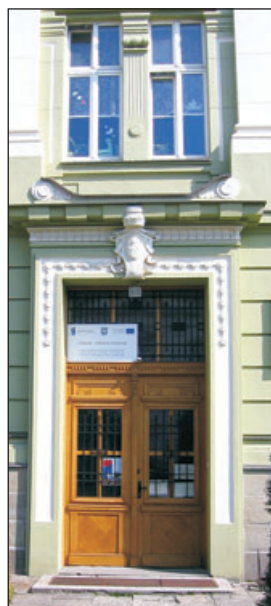
Portal główny, drzwi wejściowe.
