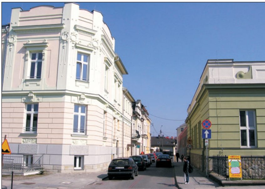
Budynek nr 9. Wyeksponowana elewacja narożna. Generalny remont w roku 2010.
