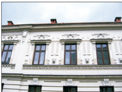
Fragment elewacji kamienicy nr 18.
