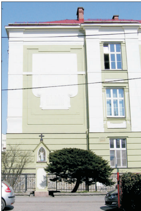
Elewacja od strony ul. Polnej z kapliczką przydrożną.
