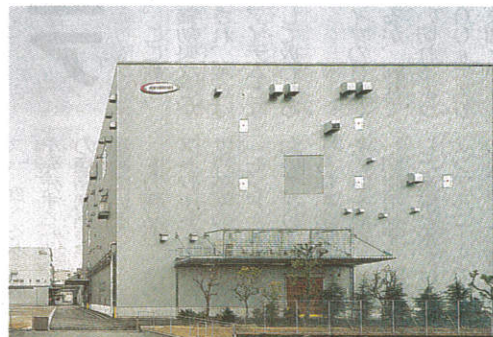
稼働を始めた岡山機能糖質工場S棟
