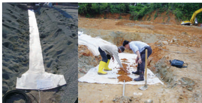
Montaż siatki geodetekcyjnej
