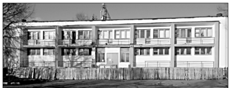
Гребная база: реконструкция не завершена
