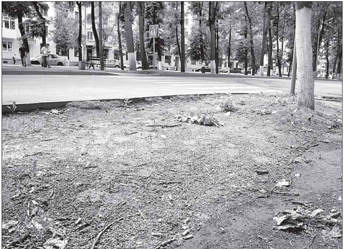
А тут и считать нечего! Так выглядит местами газон у «ворот города» - на Воскресенском бульваре, по которому приезжие следуют от вокзала к центру
