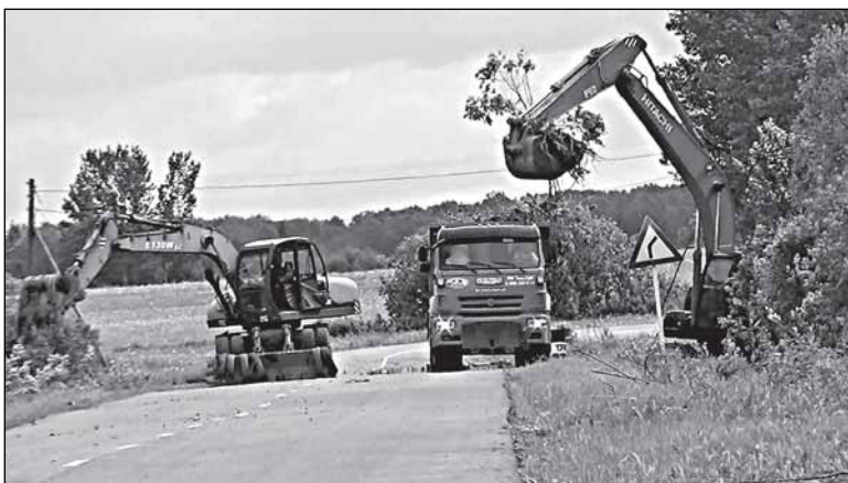
Работы на дороге, ведущей к загородной резиденции правительства
