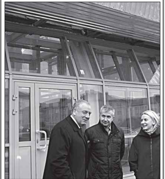
Из разговора на строящемся Маловишерском ФОКе:
