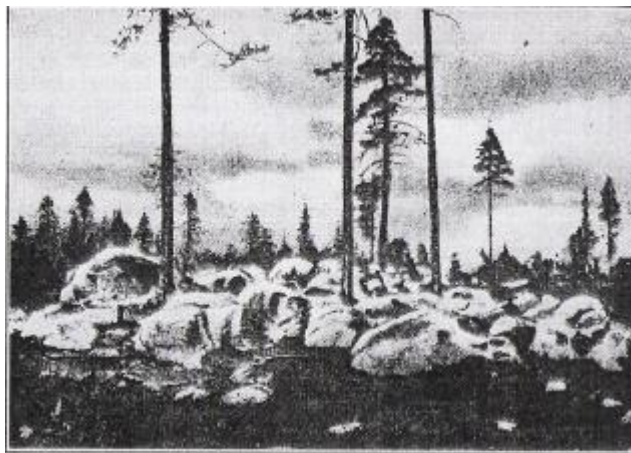
Uma visão na Sibéria. O solo está coberto com grandes rochas e pedregulhos. Por este lugar solitário e pedregoso o Canal do Mar Branco foi construído inteiramente por trabalho compulsório, o que significa que foi construído sobre sangue humano.
