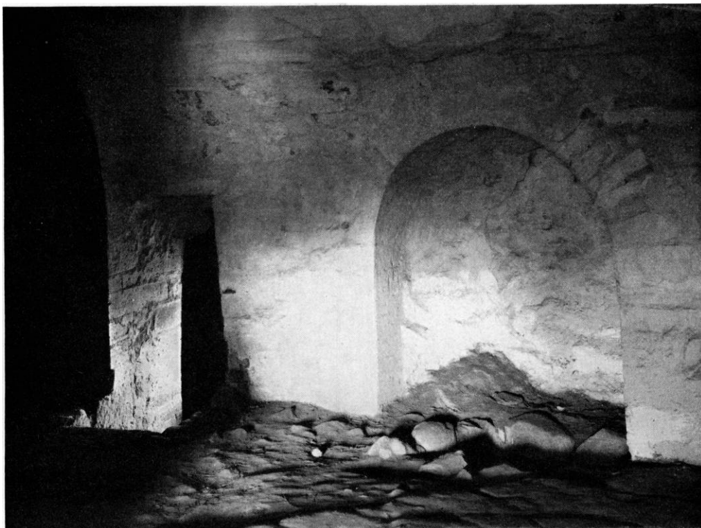
Fig. 9. Nylars kirke. Mellemstokværkets sydlige indermur. Til venstre udmunder trappen fra nederste etage (kirken), til højre ses den s. 225 omtalte niche og den af rå kampesten indfattede skakt ned gennem hvælvet.
