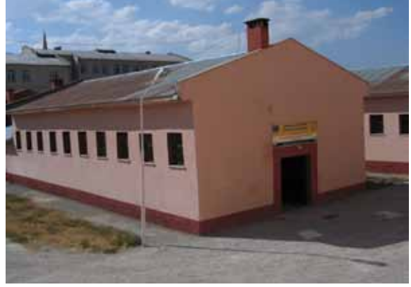
Foto 13. Eğitim atölyesi dış görünüşü.
