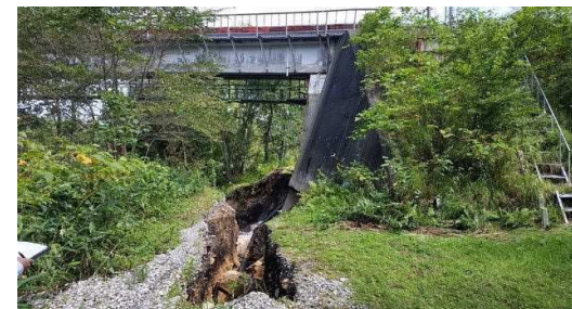
写真② 第2橋台全景
