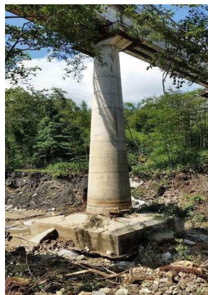
写真① 第2橋脚全景
