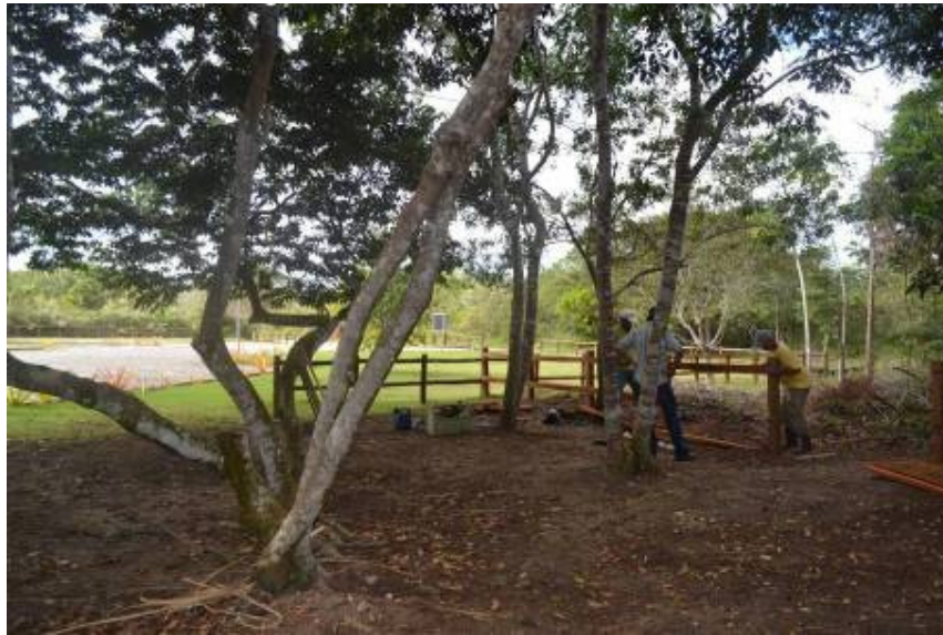
FIGURA 4.8.1-1 – Funcionários cedidos pela Prefeitura de Porto Seguro realizando instalações de infraestrutura de apoio a visitação. Foto: Carlos Ferraz
