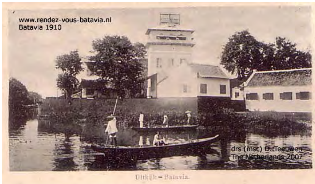
P.VII.8 Watch Tower "De Uitkijk" on Bastion Culemborg, Batavia 1910
