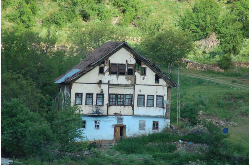
Resim 26. Eski Sleymaniye mahallesinden bir ev, Gmřhane
