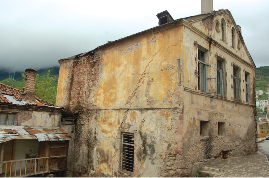
Resim 16. Eski Askerlik şubesi binası, Artvin
