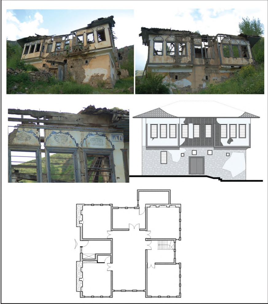
Çizim 14. Eski Gümüşhane, Süleymaniye mahallesi Kadirbeyzâde Zeki Bey Evi, Gümüşhane (1862) (S.Özgen, A. Sağsöz vd. 2007 Trabzon)
