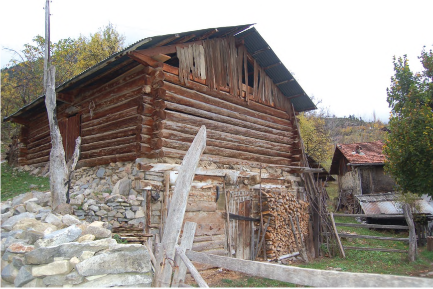
Resim 13. Kütüklerle yapılmış bir ahşap yığma servis yapısı
