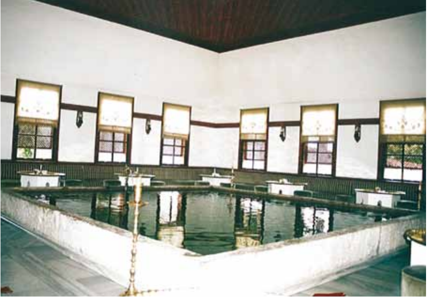
Fotoğraf 4a. Asmazlar Konağı havuzlu oda.
