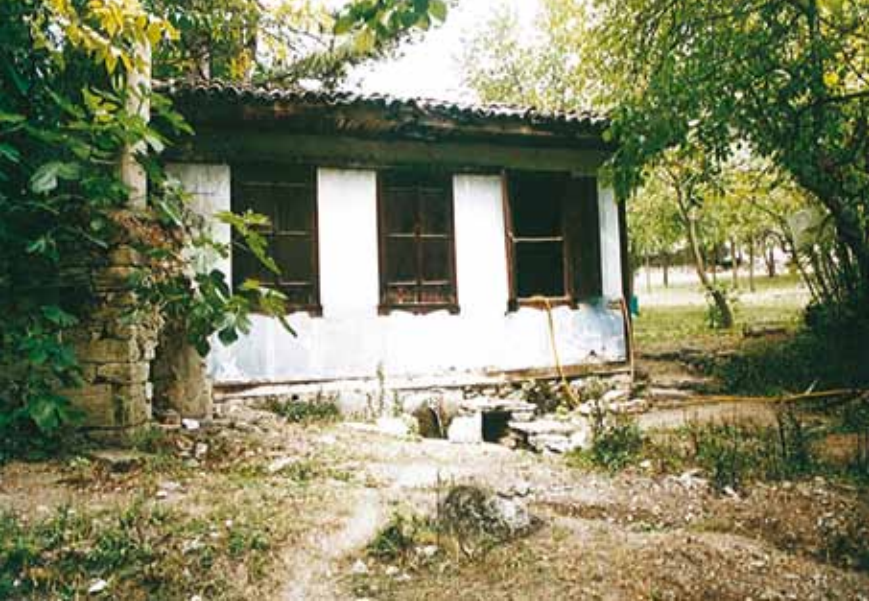
Fotoğraf 14. Kürt Ali Evi. Bahçede havuz odası. Dıştan görünüm.
