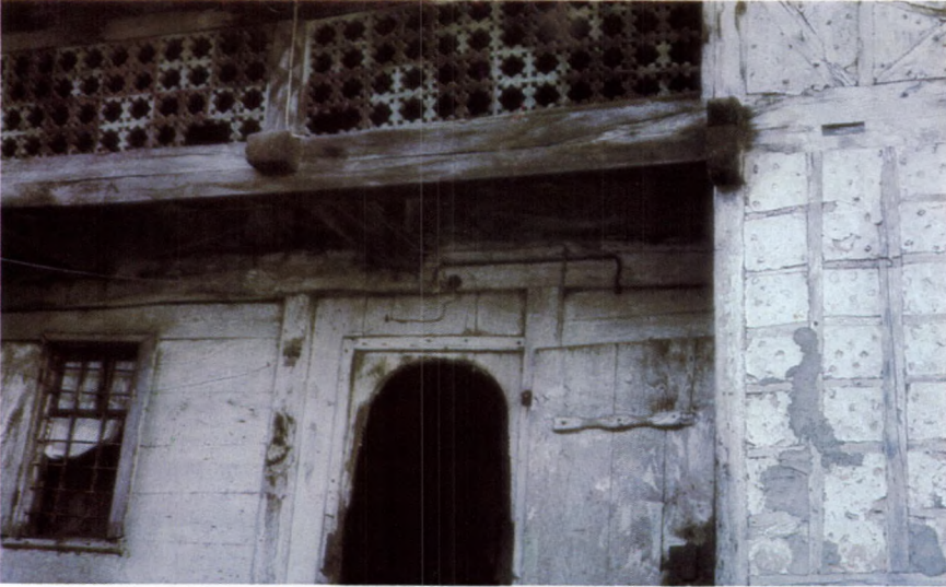
15 - Mataracı Evi , kuzeydoğu cephesinde bulunan merdiven başında 7 yer alan ahşap kafes işçiliği. Aynı işçilik yapının diğer cephelerinde yer alan kafa pencerelerinde de bulunur.
