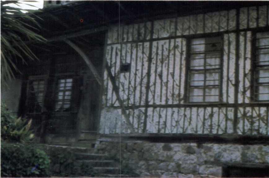
11 – Şadođlu Evi, güneydođu cephesi ve merdiven bařı. 7
