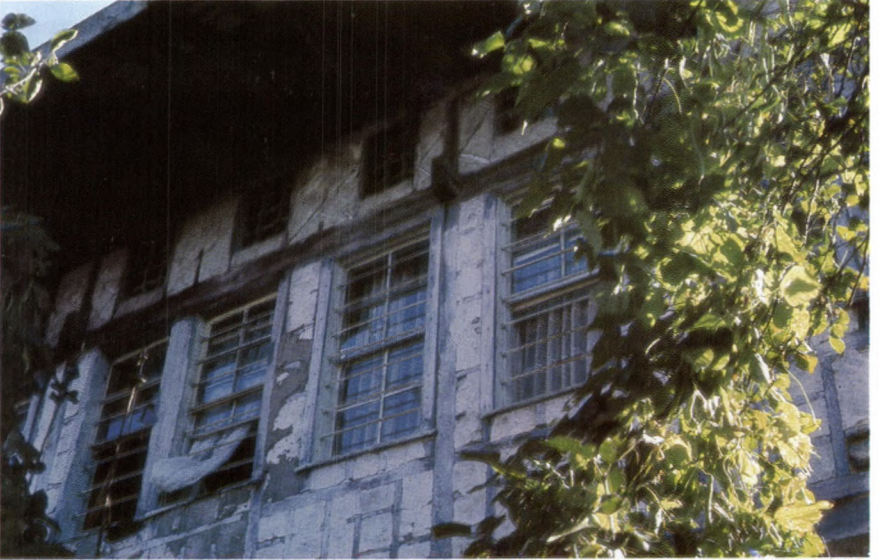
13 – Şehir merkezinin güneybatısında Yeni Köy mahallesinde 112 numaralı yapı olan Mataracı Evi 'nin yaşama ünitesinin duvarları kafa pencerelerine kadar dolap dolgu, kafa pencerelerinin bulunduğu kısım ise muskalı nakış tekniği ile inşa edilmiştir.
