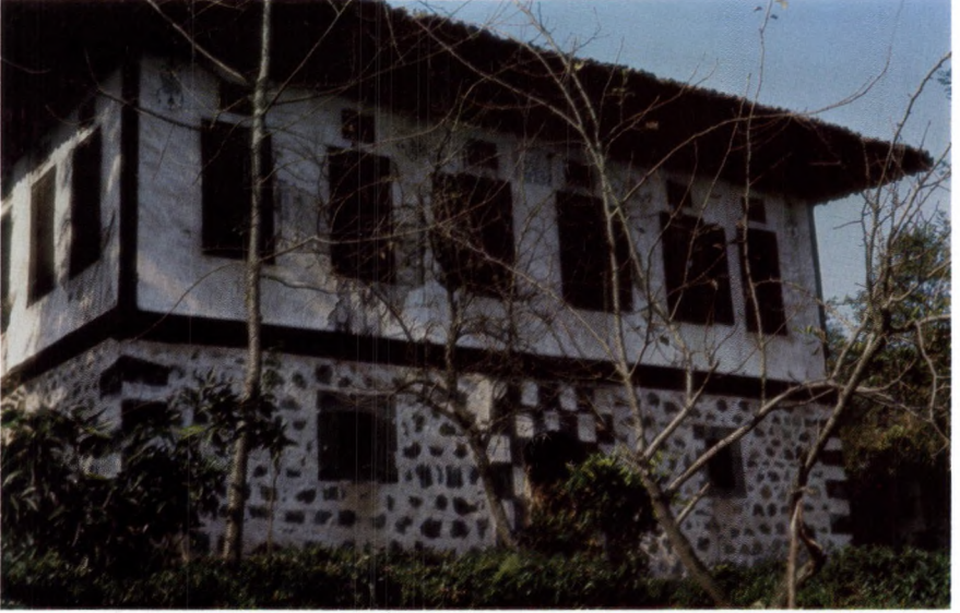
12 – Yayıcı Evi , kuzeydoğu cephesi. Yapının yaşama ünitesi muskalı nakış tekniği ile inşa edilmiş olup, üzeri sıva ile kapatılmıştır. Bu cephede yer alan boyalı nakışlar dikkat çekicidir.
