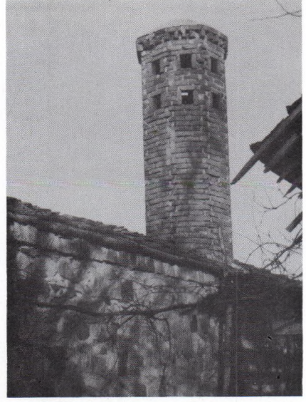
4 - Şehrin batısında, At Meydanı mahallesinde, Avcılar sokak 10 numarada yer alan Şadoğlu Evi'nin bacası.
