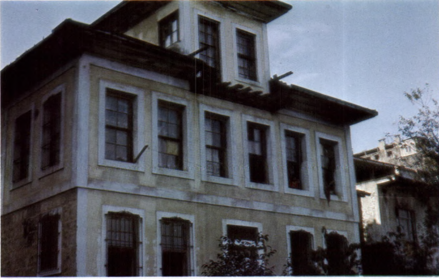
14 - Zırh Evi 'nin kuzey cephesi. İçinde bulunduğumuz yüzyılın başında yapılmış olan yapı, geç dönem özellikleri gösterir.
