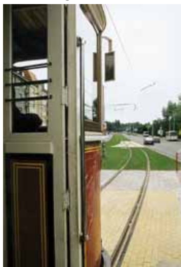
Pohled na esteticky velice příjemně působící tramvajovou trať, která zlepšuje podmínky pro pražskou MHD.
