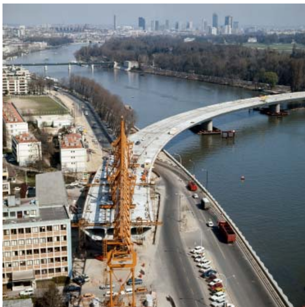
A13 construction du viaduc de St-Cloud en 1972 (photothèque DREIF)
