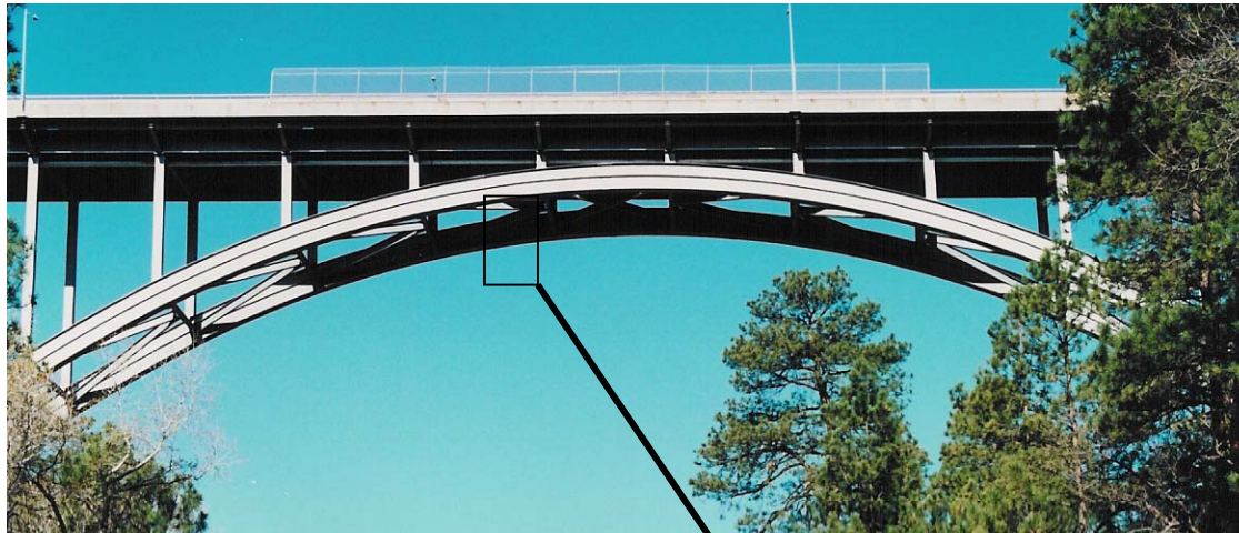
Canyon Bridge, Los Alamos, NM
