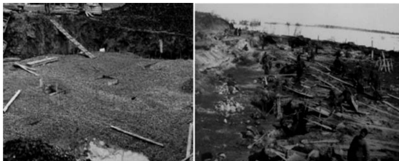
Фото 2-3. Котлован для постройки Семипалатинского мясокомбината и начало его строительства на пустыре левобережья, 1931 год (из фондов Центра документации новейшей истории Восточно-Казахстанской области)
