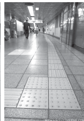
Рис. 7. Варианты применения тактильной керамической плитки для слабовидящих
