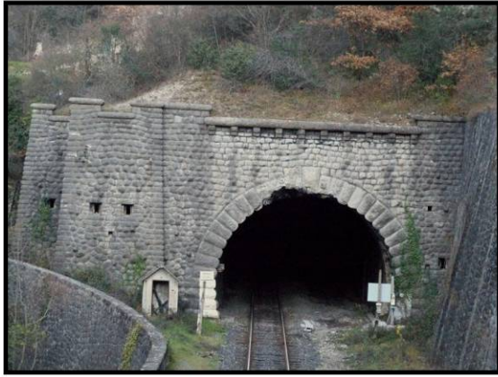
Tête du tunnel de Braus, côté Touët de l'Escarène
