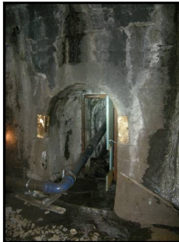
Entrée du captage
